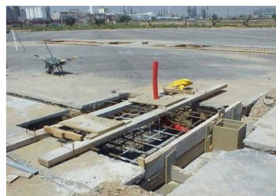
Fig. 16 bis. Aspecto de la obra, esperando a que la primera capa de hormigón fragüe.
