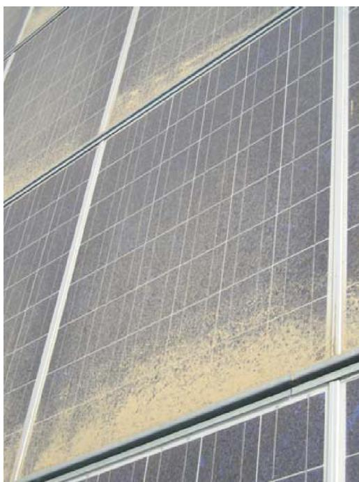
*Figura 4. Acumulaciones de polvo sobre otro generador instalado sobre cubierta de nave industrial.*
