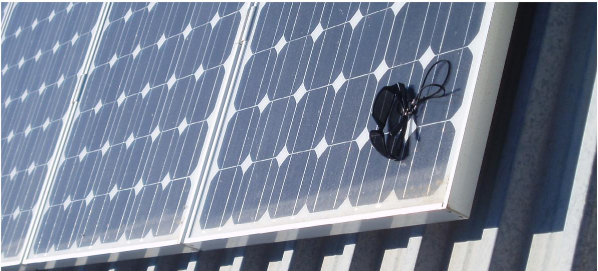
*Figura 2. Acumulaciones de polvo sobre el generador de la figura anterior. Resultan particularmente evidentes en la parte inferior de los módulos.*
