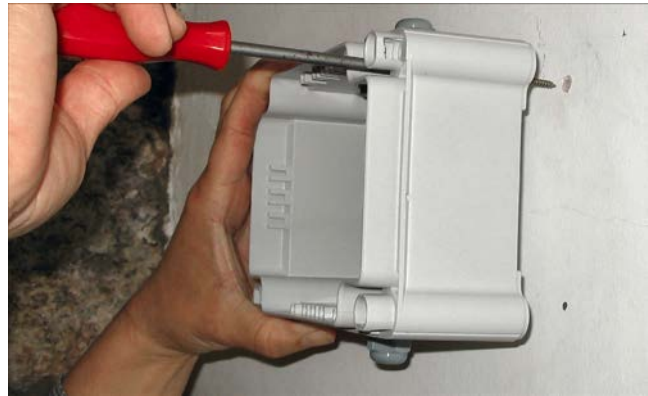
Fig. 5.20. Sujeción de la caja de conexión y medida a una superficie de apoyo. Una vez marcada la posición de los taladros y realizados éstos, la caja se fija a la pared por medio de los tornillos introducidos a través de los orificios existentes en la parte posterior de la caja.
