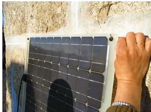
Fig. 5.23. Solución de montaje consistente en colgar el módulo en un elemento de anclaje que se hace pasar por los orificios existentes en las esquinas del propio módulo.
