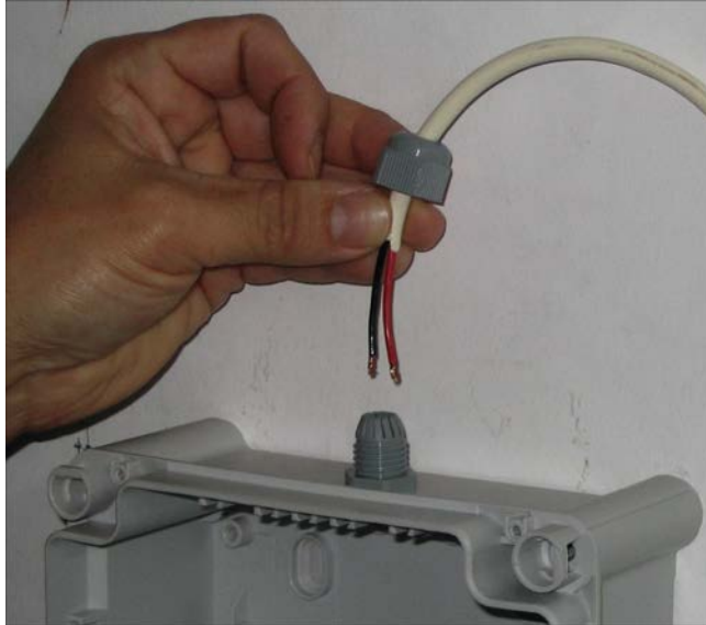
Fig. 5.10. Si además de aflojar el tapón del pasacables éste se retira, es frecuente olvidarse de introducir el cable por el tapón antes que por el pasacables. Téngase en cuenta que el efecto de prensado o apriete del cable en el pasacables se debe al roscado adecuado del tapón, por lo que su colocación es imprescindible.
