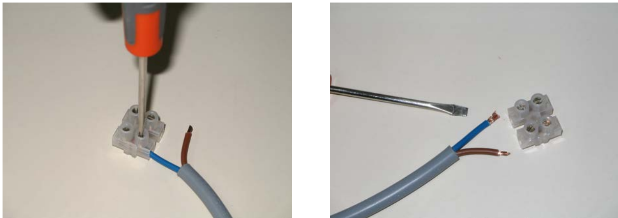
Fig. 5.7. Izquierda: operación de apriete de un terminal de conexión de tipo atornillado. Obsérvese cómo los hilos conductores quedan alojados por completo en el interior del terminal. Derecha: vista del buen estado en que han quedado los hilos conductores y la funda protectora del cable azul, una vez realizada la conexión. Obsérvese el aplastamiento de todos los hilos conductores de este cable, indicador de una conexión segura y fiable.
