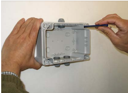
Fig. 5.20. Sujeción de la caja de conexión y medida a una superficie de apoyo. Una vez marcada la posición de los taladros y realizados éstos, la caja se fija a la pared por medio de los tornillos introducidos a través de los orificios existentes en la parte posterior de la caja.
