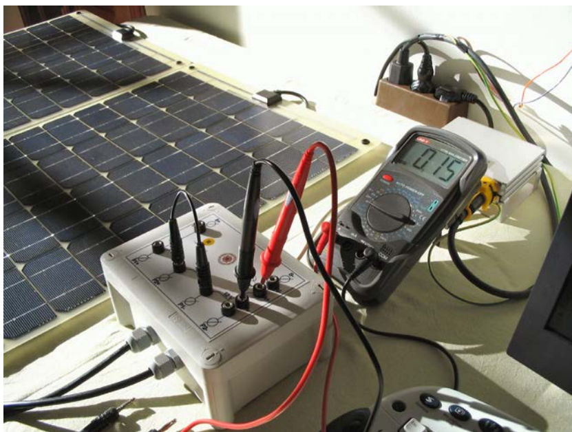
Fig. 5.30. Medición de la corriente entregada por el generador fotovoltaico. Obsérvese dónde se deben situar las sondas del multímetro, tanto en la caja de conexión y medida como en el propio multímetro, y cómo el inversor debe estar conectado a la red.
