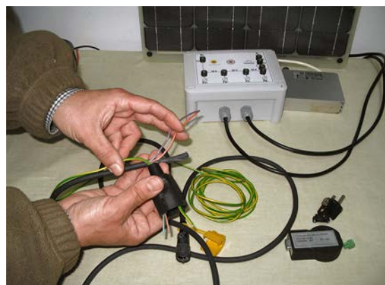
Fig. 5.12. Secuencia de preparación del cable de salida del inversor OK4. Tras realizar un pequeño corte longitudinal en la funda protectora exterior del cable (imagen superior), se puede romper y retirar fácilmente dicha funda sin más que tirar a la vez de los cables interiores y de ésta (imagen central). Esta separación de la funda debe dejar accesibles los cables de conexión a red, con una longitud que permita conectar con facilidad la clavija de enchufe. En la imagen inferior se aprecia cómo el trozo de funda retirada aún no es suficiente para permitir dicho conexionado.
