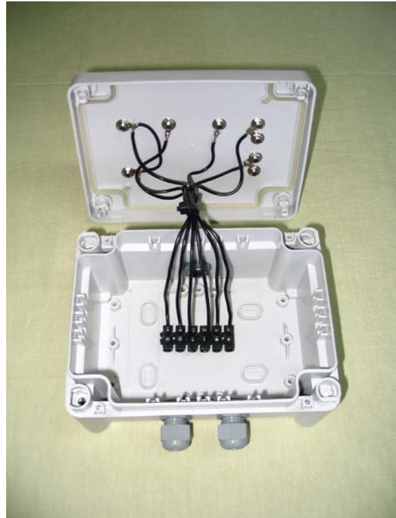
Fig. 5.4. Vista del interior de la caja de conexión y medida. Obsérvanse los cables que unen los bornes exteriores de la tapa de la caja con la regleta interior de conexiones, donde se conectarán los módulos fotovoltaicos y el inversor.
