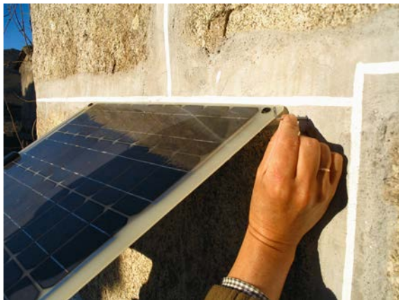
Fig. 5.23. Solución de montaje consistente en colgar el módulo en un elemento de anclaje que se hace pasar por los orificios existentes en las esquinas del propio módulo.
