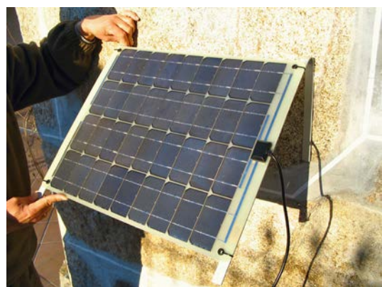
Fig. 5.26. Otra posibilidad consiste en emplear perfiles metálicos planos normalizados, habitualmente disponibles en tiendas especializadas y grandes superficies comerciales, para formar una sencilla estructura soporte cuya fijación se puede llevar a cabo utilizando métodos convencionales. Obsérvese nuevamente la utilización de las bridas de plástico para sujetar, en este caso, los perfiles metálicos al módulo.
