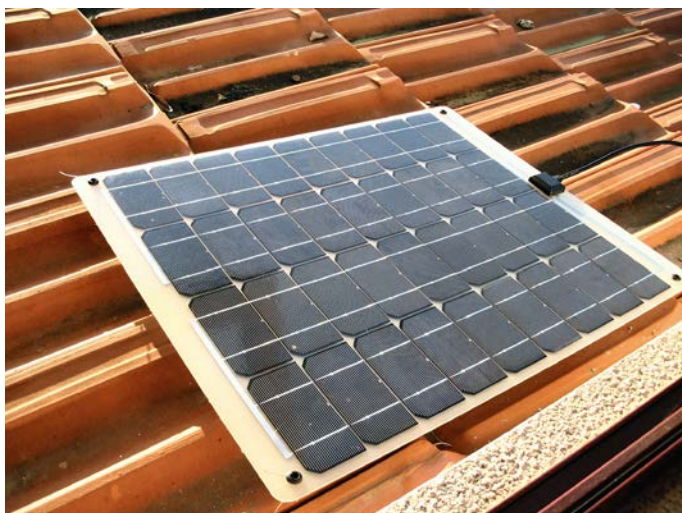
Fig. 5.24. La fijación del módulo sobre un tejado se puede resolver haciendo pasar un alambre por entre las tejas y doblando las puntas en los orificios del módulo.
