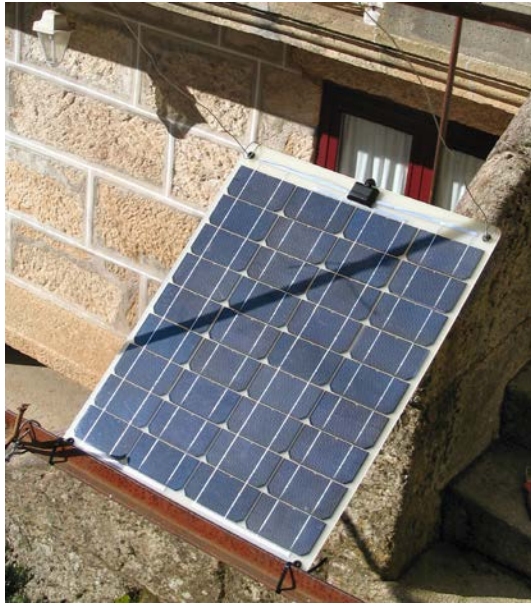
Fig. 5.25. La solución mostrada en estas imágenes permite modificar fácilmente la inclinación del módulo, deslizándolo por los alambres que pasan por sus orificios superiores. Obsérvese la utilización de las bridas de plástico para sujetar la parte inferior del módulo.
