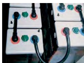
Figura 23. Ejemplos de conexión de elementos acumuladores de 2 voltios mediante pletinas de interconexión (izquierda) y cable flexible (derecha). En ambos casos, todas las partes con tensión están convenientemente aisladas para protección contra contactos accidentales.
