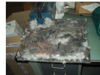
FIGURA 6.11: Efectos del funcionamiento de un diseño defectuoso de una caja de protecciones que incluye varistores.
